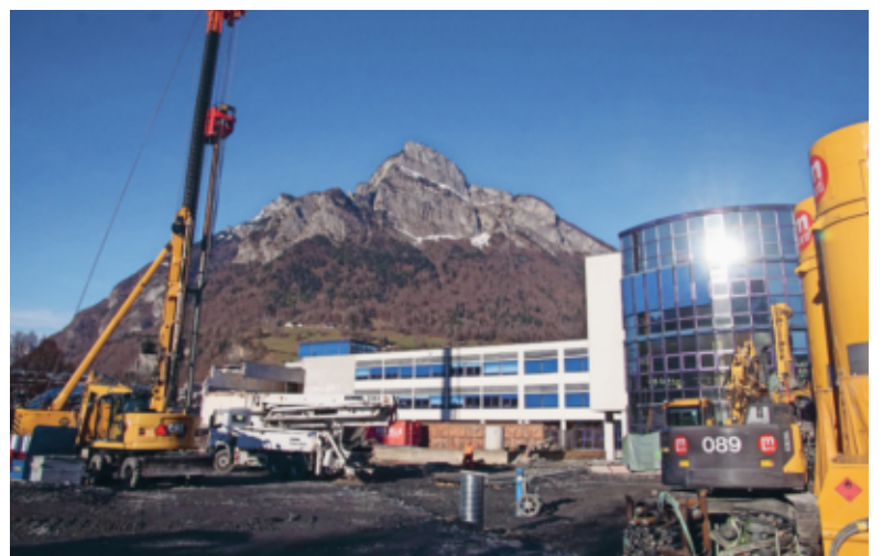
Grossbaustelle auf dem Kanti-Areal: Zuerst muss das Alte abgerissen werden, bevor das Neue entsteht. (Bilder Ursi Schmid)
