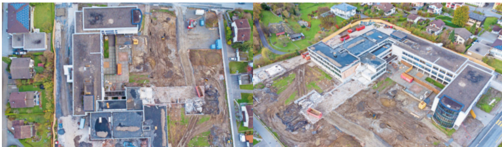
Aus der Drohnenperspektive: Blick auf die Kanti-Grossbaustelle (Bilder Sarganserländer)
